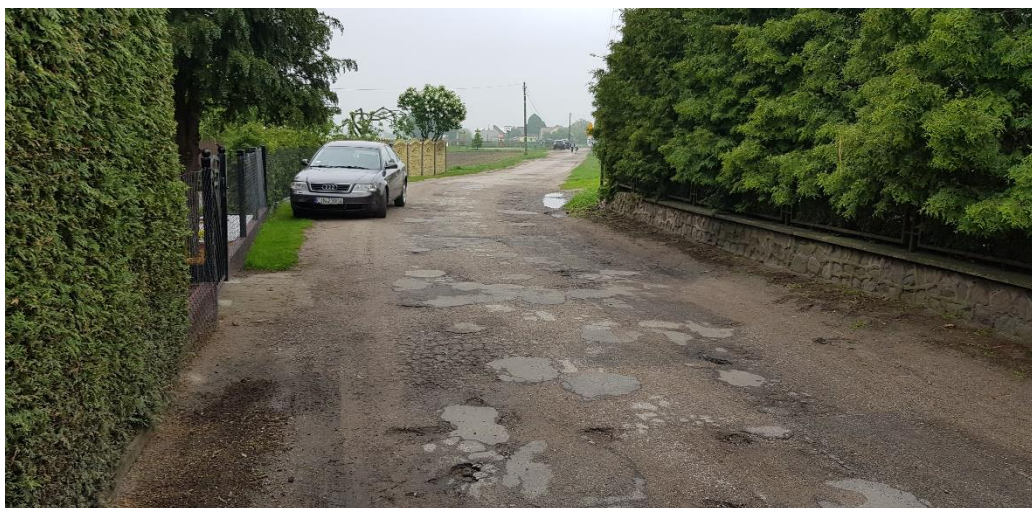
Fot. 1. Droga gminna w Pieraniu (widoczna retencja wody oraz zły stan nawierzchni drogi).
