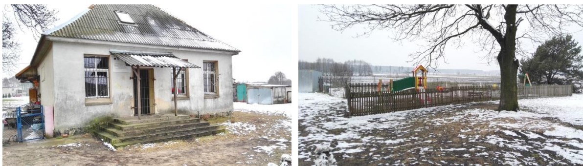
Nowy Dwór. Widok na budynek świetlicy wiejskiej oraz placu zabaw przy świetlicy
