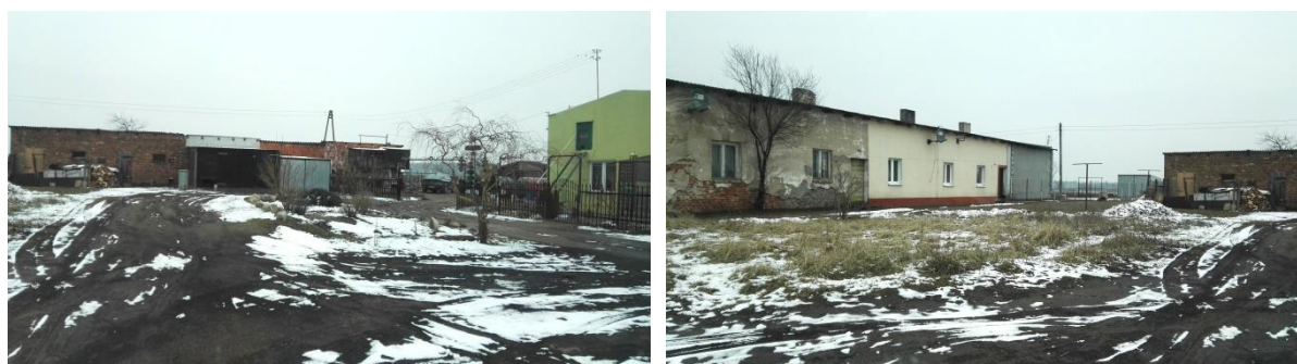
Pieczyska. Widok na zabudowania mieszkalne i gospodarcze
